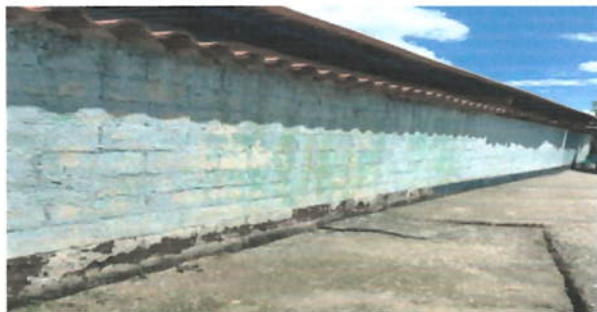
FOTO1: PINTURA EN MUROS INTERIOR Y EXTERIOR
