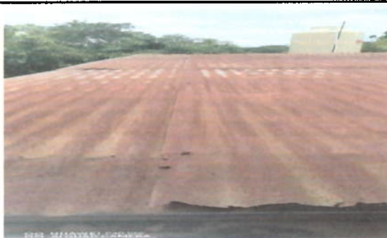
FOTO5: CUBIERTA DE LAMINA
